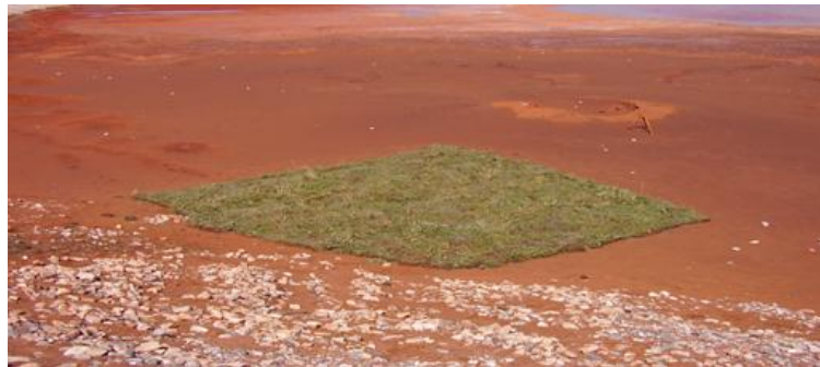
Рис. 1. Розміщення дернини на шламосховищі МГЗ
