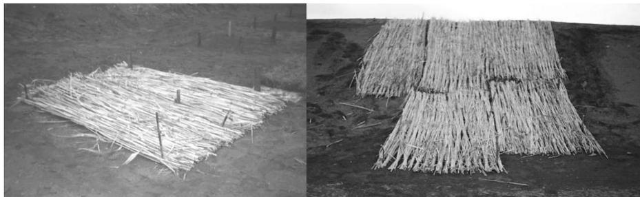
Рис. 3. Схема укладки камышовых матов на пляжах (а) и склонах (б) поверхности хвостохранилищ
