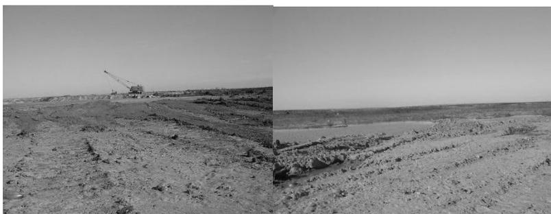
**Рис. 4.** Создание плодородного слоя предотвращает ветровую эрозию (хвостохранилище № 1 Николаевского глиноземного завода)
